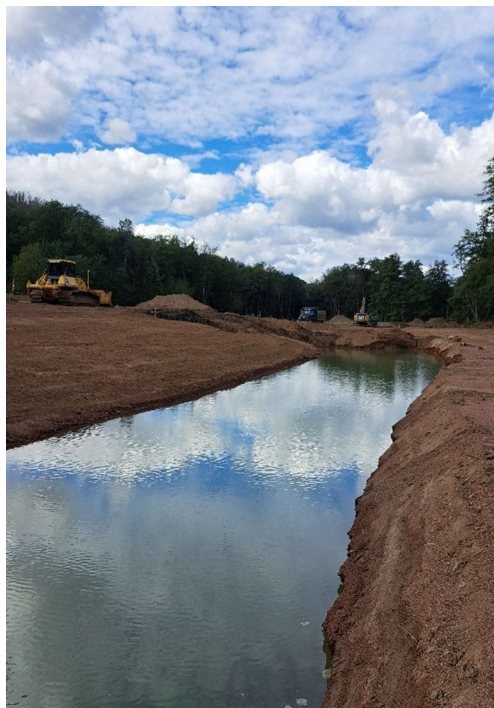
Stavba nového rybníka u Trucálek
