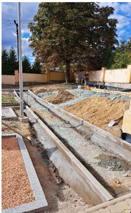
Stavba kolumbária na hřbitově v Tikovicích
